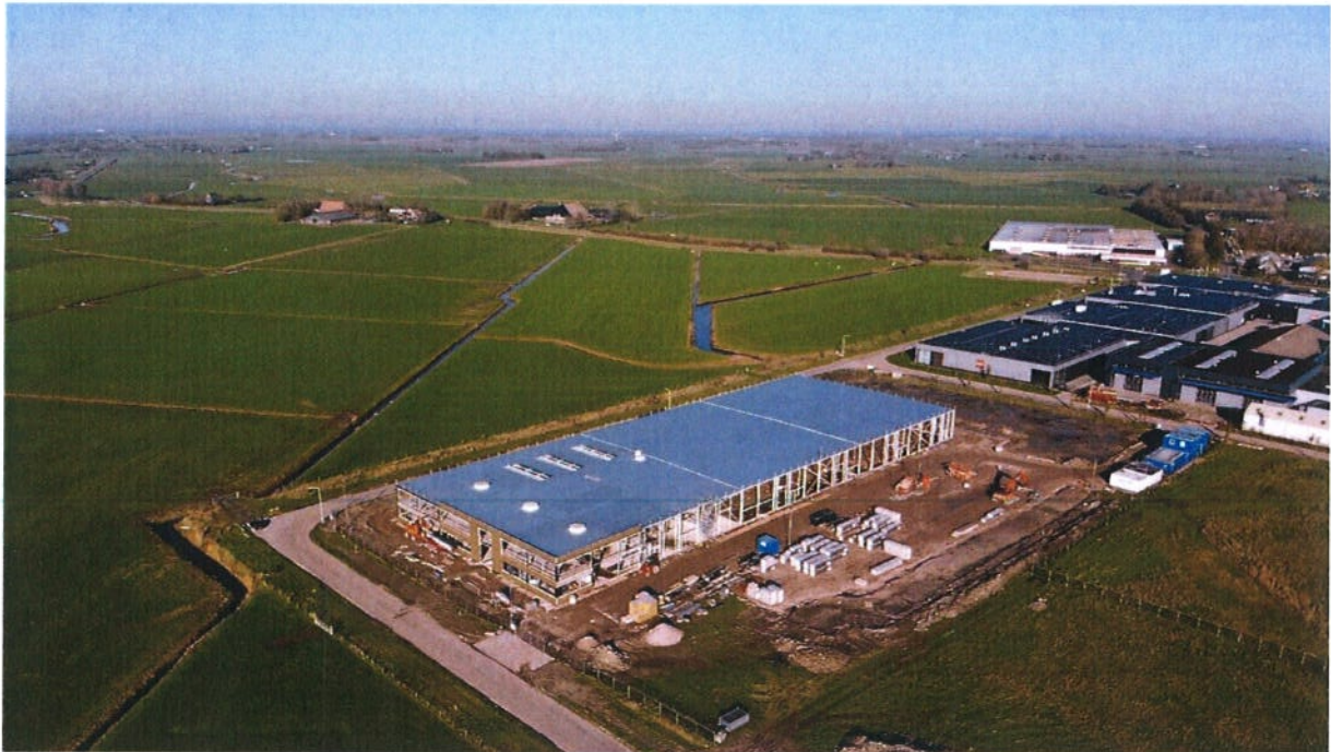
Bovenstaande foto is met een drone genomen en geeft een mooie impressie van de stand van zaken in het werk (eind 2020), maar ook hoe het nieuwe pand is gesitueerd in het landschap.
